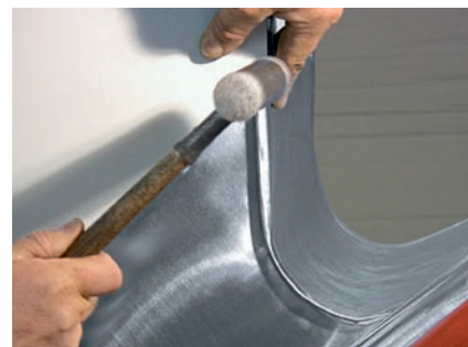
Réalisation du joint
