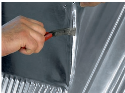
Réalisation du joint simple
