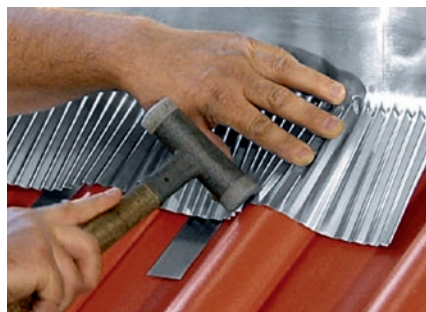
Ajustement du plissage
