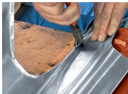
Préparation du joint de la pièce latérale
