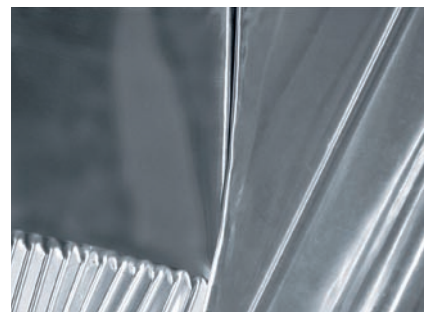
Finition du joint simple
