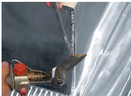
Soudure côté égout
