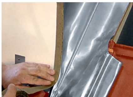
Pose de la bande adhésive
