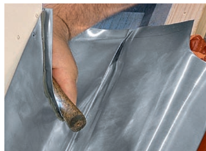
Pression sur le recouvrement
