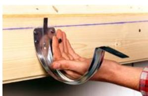
Fixation sur bandeau de toit : crochets à dos plat
