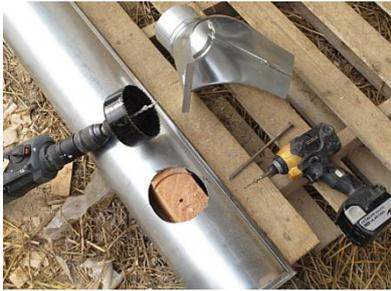
Tracez le contour du trou d'évacuation puis percez à l'aide d'une scie cloche (le diamètre du trou percé doit correspondre au diamètre de la descente)
