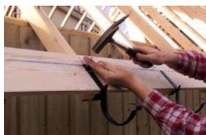
Fixation sur chevron : crochets à hampe (utilisez des crochets à hampe chantournée pour une fixation sur le côté du chevron)
