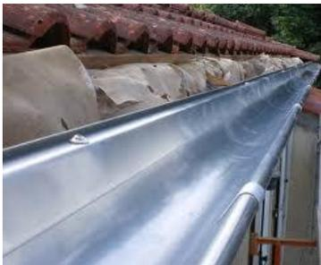
Disposez votre gouttière sur les crochets et rabattez les paillettes des crochets afin de la fixer
