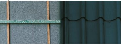
Rénovation sur bardeaux bitumées, on peut appliquer la méthode 'toiture-sur-toiture'.
