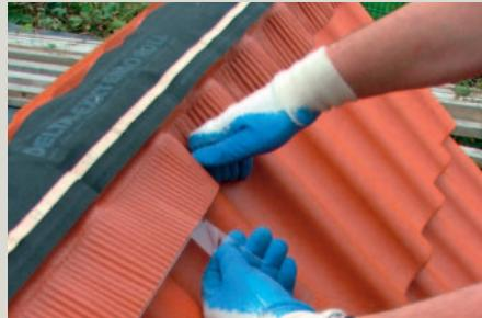
3. Retirer ensuite progressivement le film pelable puis maroufler les jupes latérales en aluminium du haut vers les bas en suivant le profil de la tuile. Le support doit être propre, sec et exempt de poussières.
