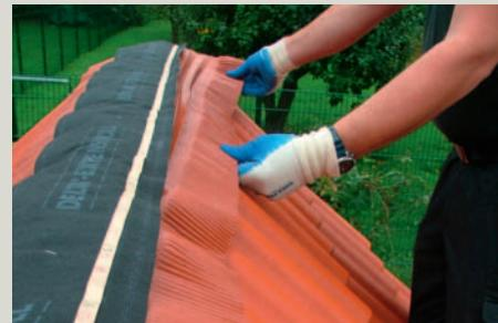
2. Les jupes latérales extensibles sont réglées en fonction du profil de la tuile et positionnées de manière à assurer le recouvrement complet de la tuile.
