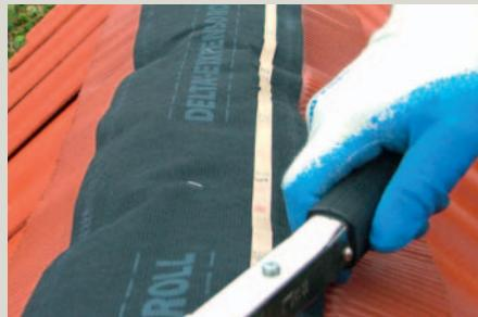
1. La pose est réalisée à froid en déroulant et centrant le closoir DELTA®-EXXTENSO ROLL sur le faîtage ou l'arêtier puis en le fixant mécaniquement à l'aide d'agrafes ou de pointes sur la lisse de rebasse.
