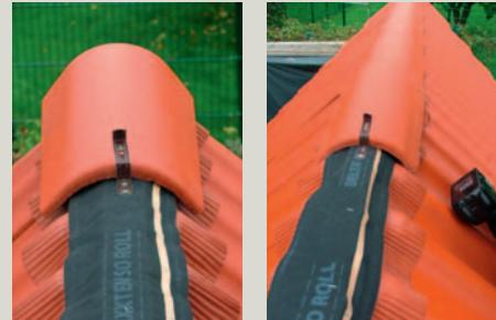
4. Les faîtières sont enfin positionnées puis fixées mécaniquement à l'aide de crochets de faîtière.
