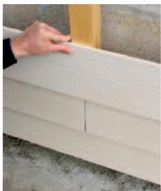
⑤ Pose, rangée par rangée en décalant les joints
