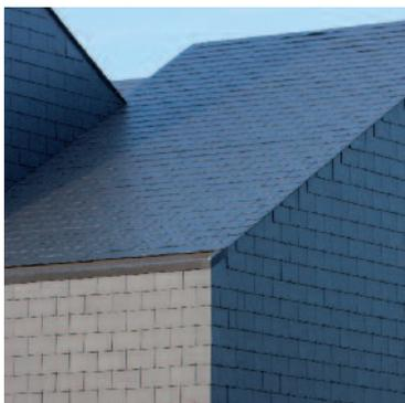
Offrez-vous de nouveaux débouchés professionnels ! Avec les ardoises fibres-ciment Vertigo, vous détenez la solution idéale en bardage comme en couverture. Créez une continuité dans la construction en utilisant le même matériau sur
