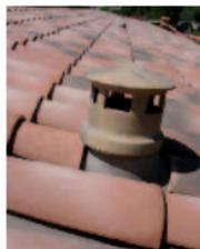
3. Pose de la lanterne terre cuite (Ø 150 – 180 mm intérieur) avec un joint de colle polyuréthane (type Sikaflex 11FC)
