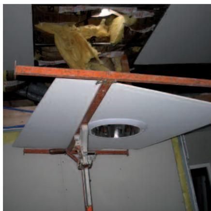
6. Découper le plafond et placer le diffuseur. Ensuite, emboîter le tube d'arrivée au conduit.
