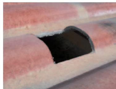
2. Position du trou sur la 3<sup>ème</sup> onde de la Soutuile 230 de dimensions 20x20 cm pour le passage de la VMC
