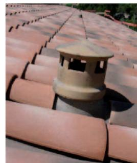
3. Pose de la lanterne terre cuite (Ø 150 – 180 mm intérieur) avec un joint de colle polyuréthane (type Sikaflex 11FC)
