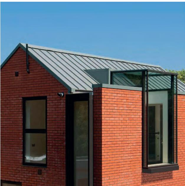
*Réalisation tertiaire avec le profil joint debout, finition anthracite.*
