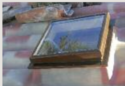
Pose de la fenêtre de toit
