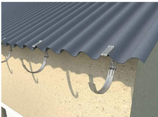
La fixation des gouttières sur plaques ondulées en fibres-ciment suit le même principe que la fixation sur bac acier.
